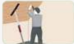
Sujeción y nivelación de trabajos.
